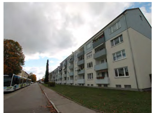
Abb.: 341: Birkenstraße, Bestandssituation
