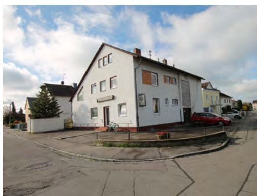
Abb.: 357: Brunnebachstraße, Bestandssituation
