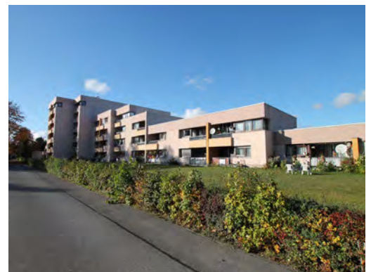
Abb.: 343: Margeritenstraße, Bestandssituation
