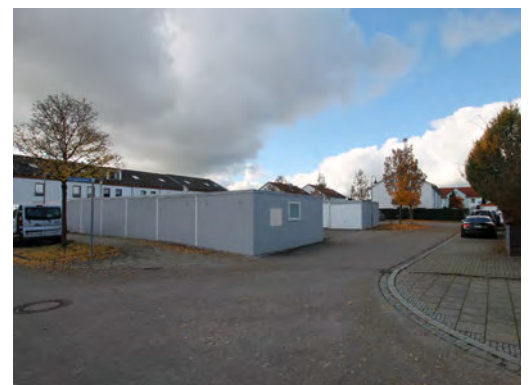
Abb.: 379: Forgensesstraße, Bestandssituation
