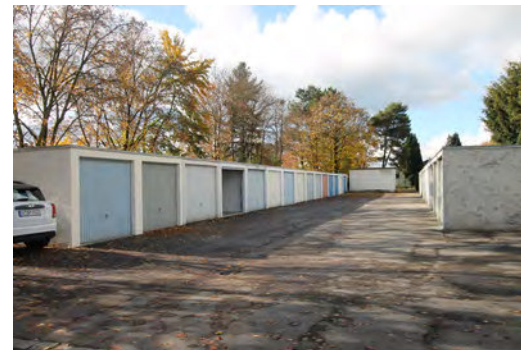
Abb.: 377: Kempster Straße, Bestandssituation
